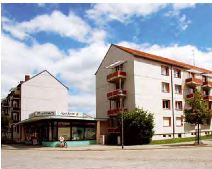
Auch Gewerbetreibende wie die Apotheke werden Wärme aus dem BHKW am Standort Burg beziehen.
