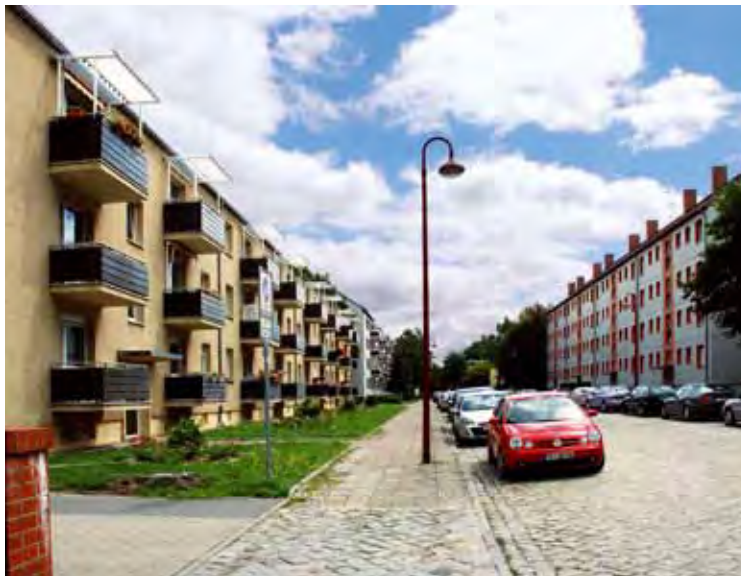
Rund 270 Wohnungen in der Goethestraße, Lindenallee und Bahnhofstraße werden künftig mit Fernwärme versorgt.
