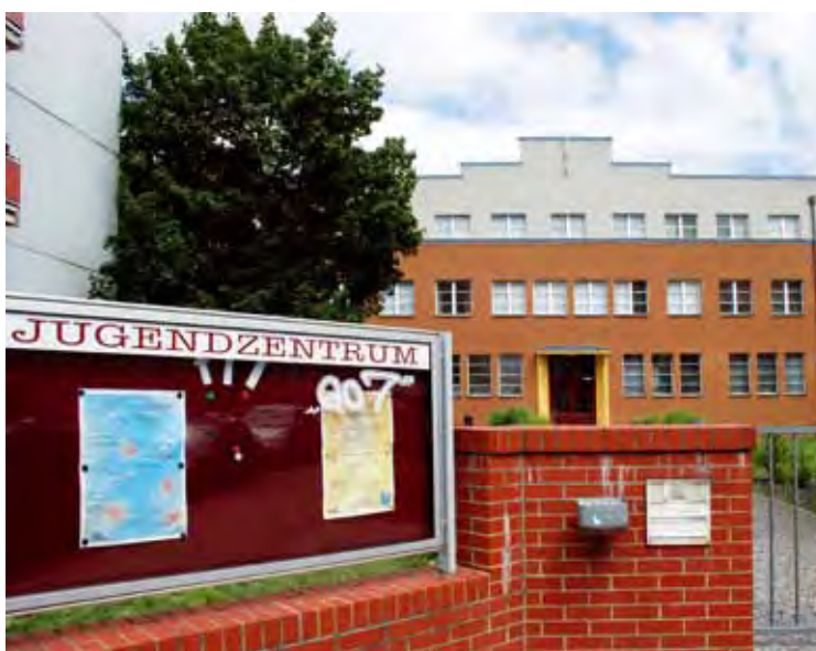
Zu den neuen Nutznießern des komfortablen Fernwärme-Bezuges gehört auch das Jugendzentrum in der Goethestraße. Im Keller des Hauses befand sich die bisher genutzte Kesselanlage.
